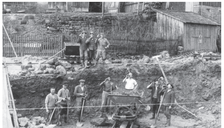
Erdaushub Feuerweiher, 13. bis 21. März 1957
