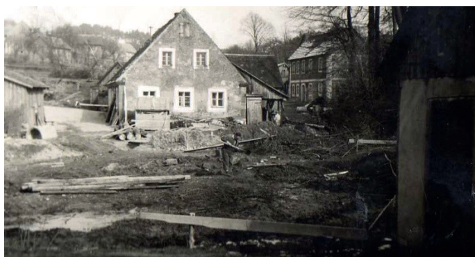
Beginn Aushub Feuerweiher 1957
