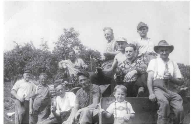
Abschluss Wirtschaftsweg Laibachwiesen 1955
